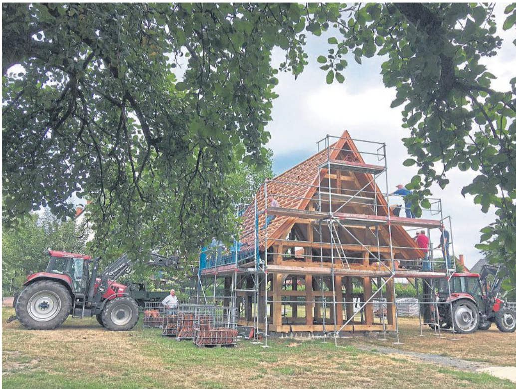
Am kommenden Sonnabend wird in Liebenau Richtfest gefeiert. FOTO: SOMMERFELD
