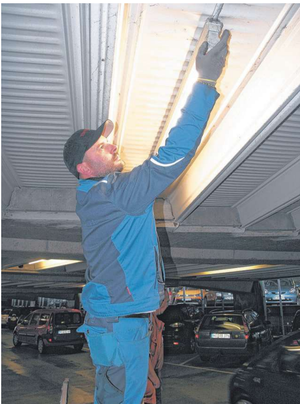
Im Parkhaus am Bahnhof wurde bereits auf LED-Technik umgestellt.
