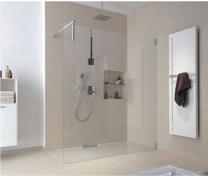
Eine ebenerdige Dusche ermöglicht es Seniorinnen und Senioren, der Körperpflege eigenständig nachgehen zu können.
