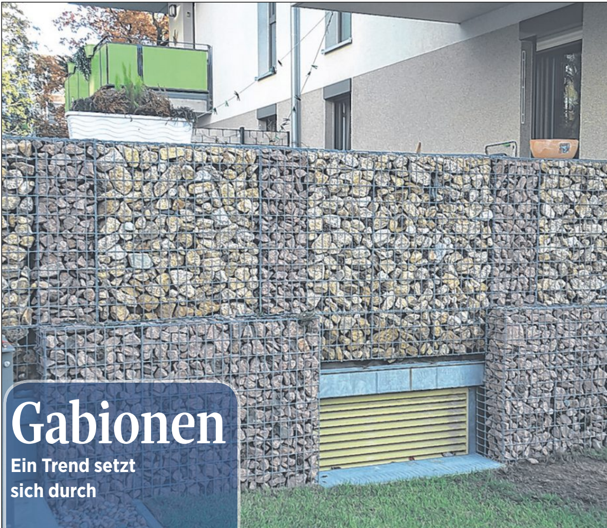
Gabionen als Trennwände FOTO: BUSCHÉ
