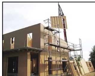
Hinter dieser Fassade steckt auch ein Holzrahmenbau
