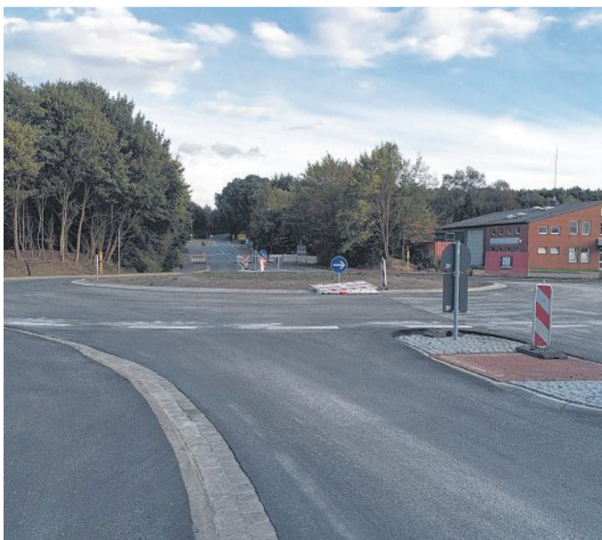
Der Kreiselneubau an der Hannoverschen Straße bei Langendamm endet voraussichtlich am kommenden Mittwoch. Ab Donnerstag soll der Verkehr wieder fließen. FOTO: DUENSING
