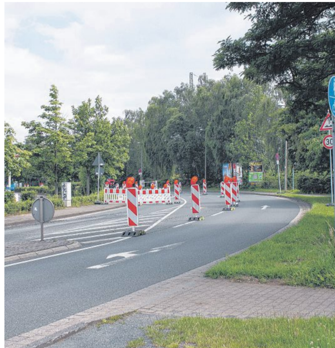
Der Kräher Weg ist am 10. sowie am 17. Juli wegen Straßenbauarbeiten voll gesperrt.
