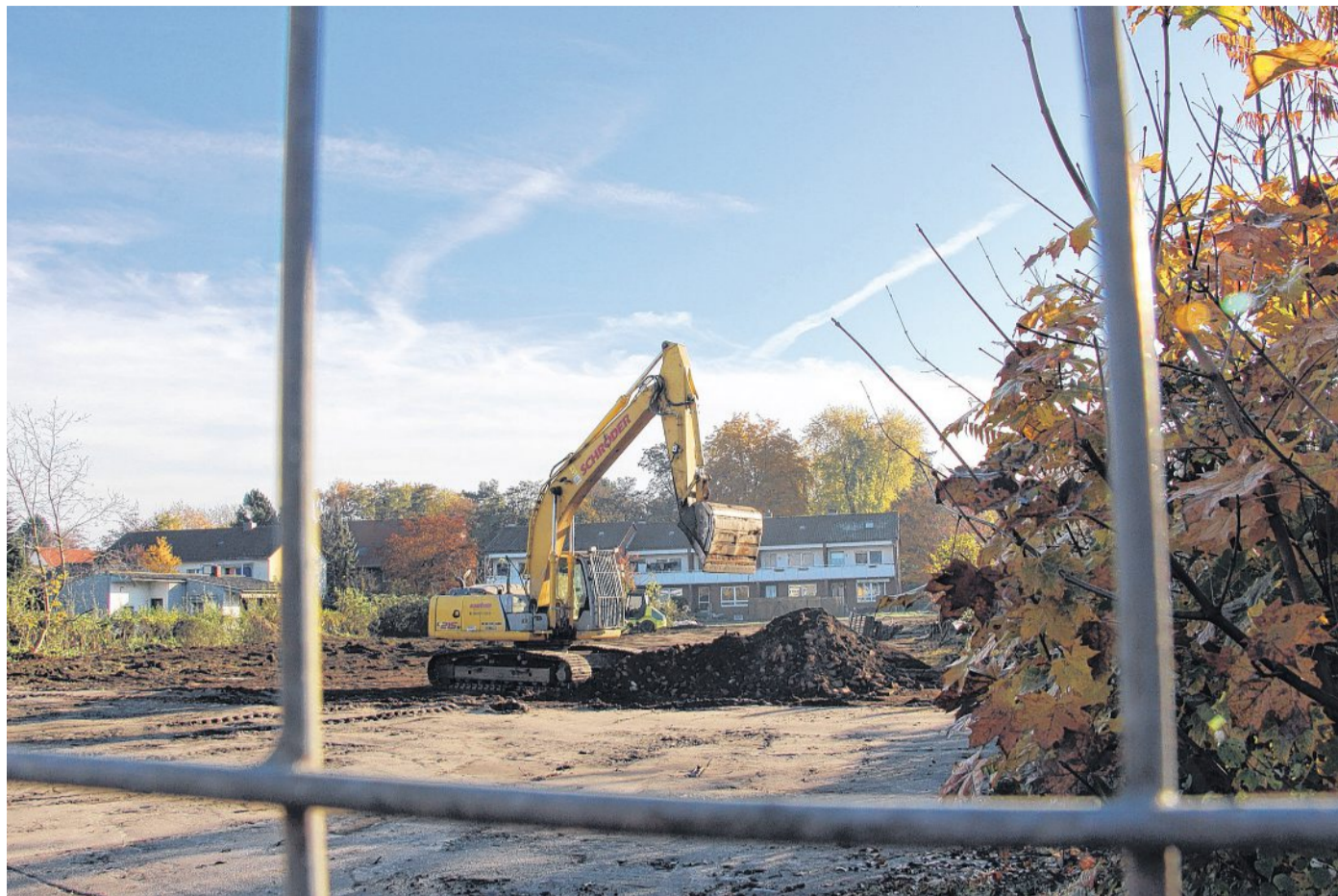
Freier Blick auf die Verdener Landstraße: Im Nienburger Nordertor sind die Abrissarbeiten weitestgehend abgeschlossen. Die GBN will den Bereich zu beiden Seiten der Wilhelm-Rösler-Straße zunächst einzäunen und begrünen. Hagebölling
