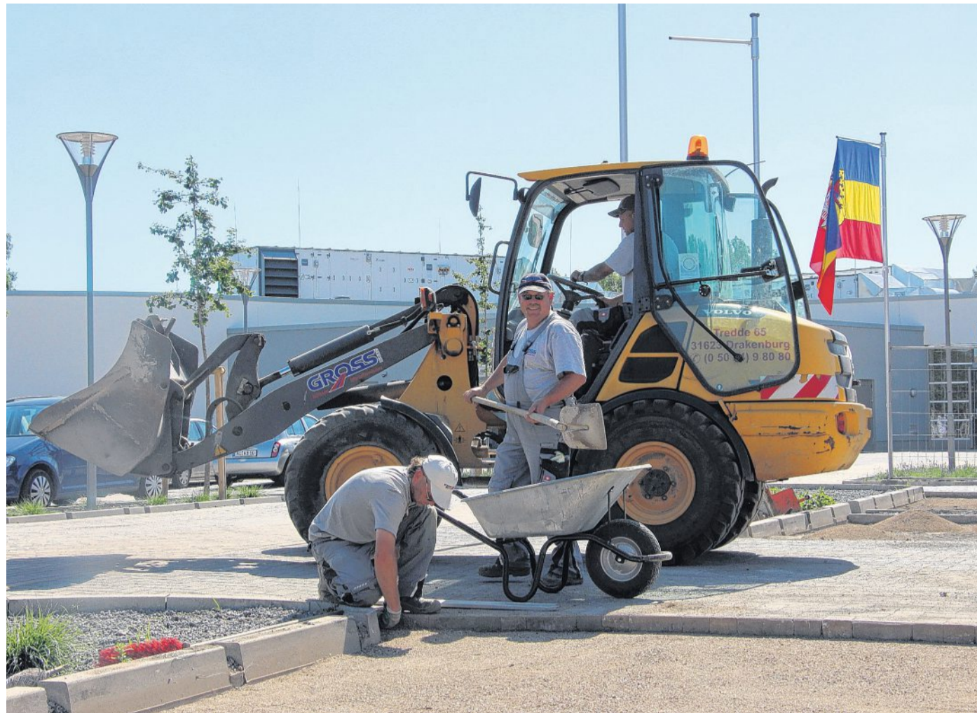
Jetzt wird der alte Theaterparkplatz doch noch erneuert. Weil sich die alten Steine nicht so ausrichten ließen, wie gewünscht, und weil noch Geld vorhanden war, werden zurzeit 90 Parkplätze erneuert. Jeder einzelne ist dann auch 2,50 Meter breit. Hageböling
