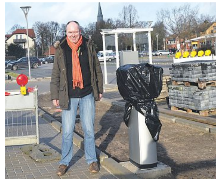
An der Ausfahrt steht zurzeit nur eine Fahrspur zur Verfügung. Bisher Unbekannte hatten die Säule für die Schranke mit einem Böller zerstört und damit einen Schaden von rund 7 500 Euro verursacht. Tom Hesse hat für Hinweise eine Belohnung von 300 Euro ausgesetzt.
