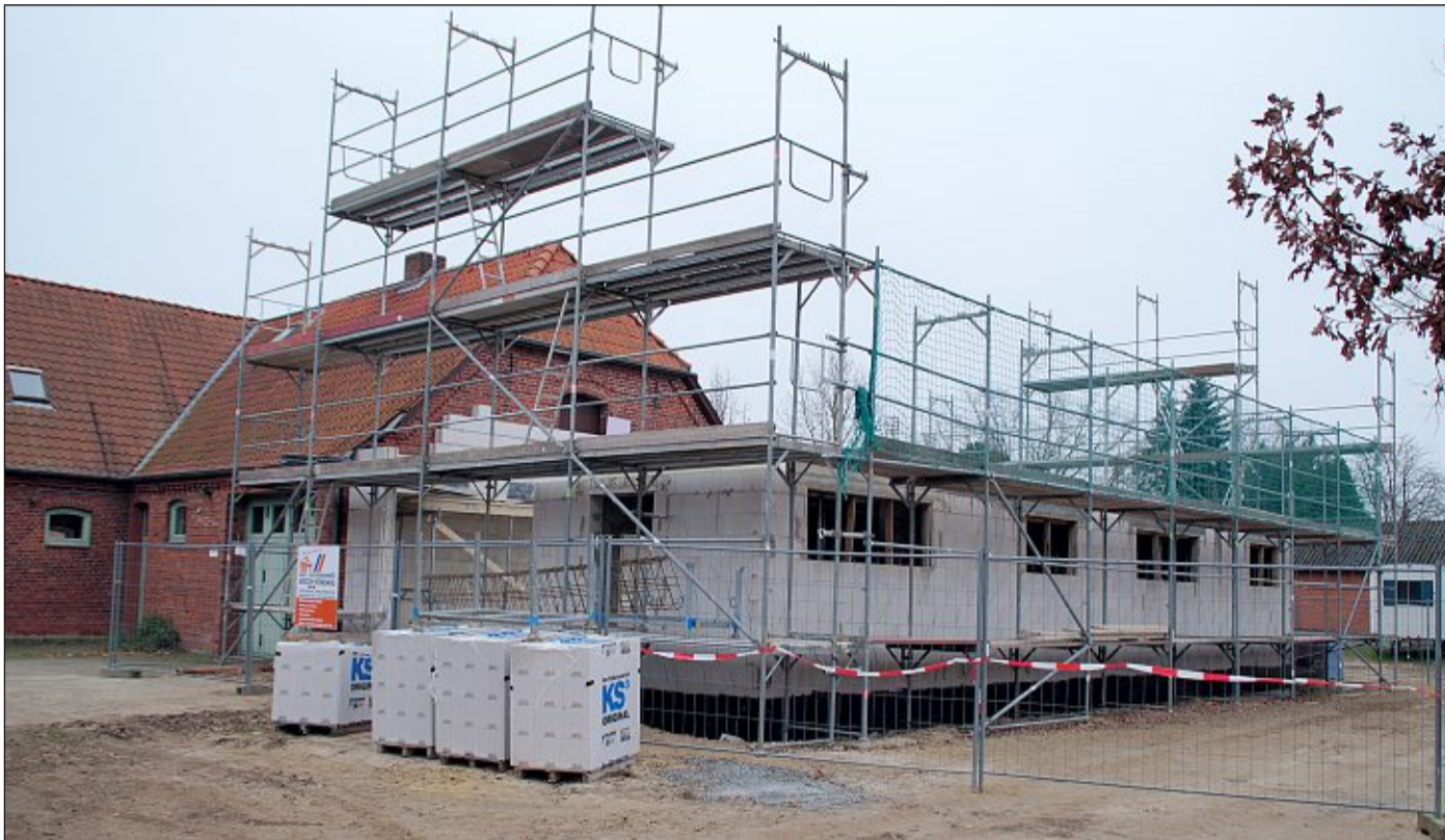
Das Balger Feuerwehrgerätehaus wird erweitert.
