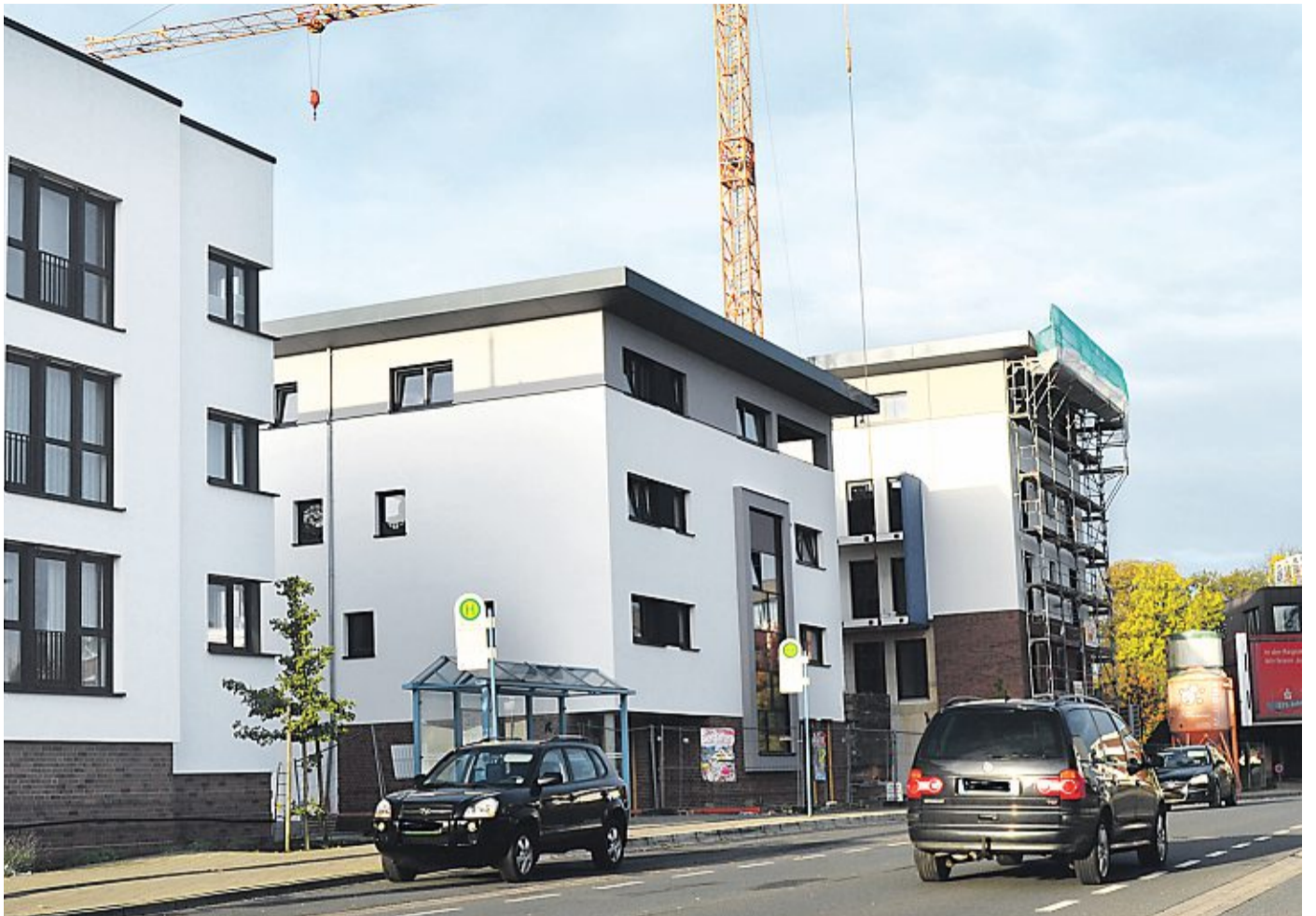
Noch müssen sich die Fahrgäste an der Marienstraße mit einer Wartehalle begnügen, sobald die Fundamente der beiden anderen gerichtet sind, werden aber auch diese wieder aufgebaut. Hagebölling
