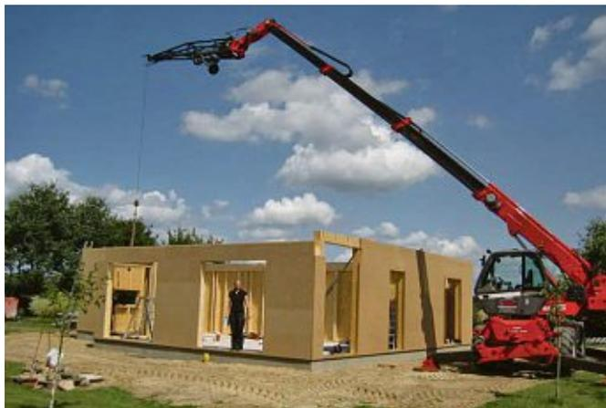
haus vereint. Innerhalb weniger Tage wurde das als Ausbauhaus konzipierte Gebäude durch Firma Hestermann aufgestellt, gerichtet und das Dach gedeckt.
