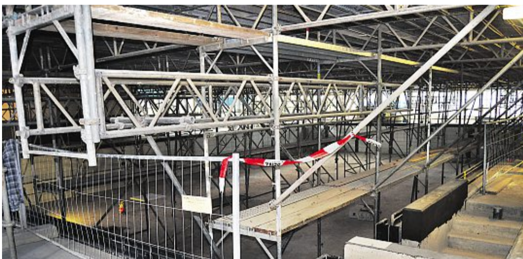
Baugerüstwarrwar im Sportbecken. In Kürze wird die Deckenverkleidung angebracht, anschließend kommen die Fliesenleger.
