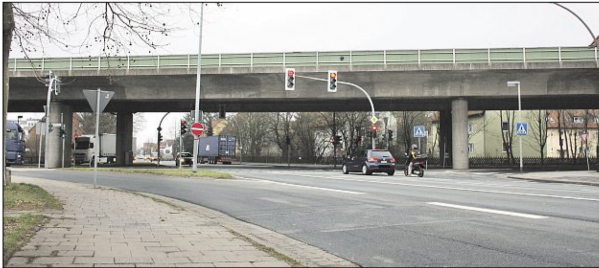
Der Nordring-Kreisel wird kommen: Dieser soll die Verkehrssituation auf der Verdener Landstraße entspannen.
