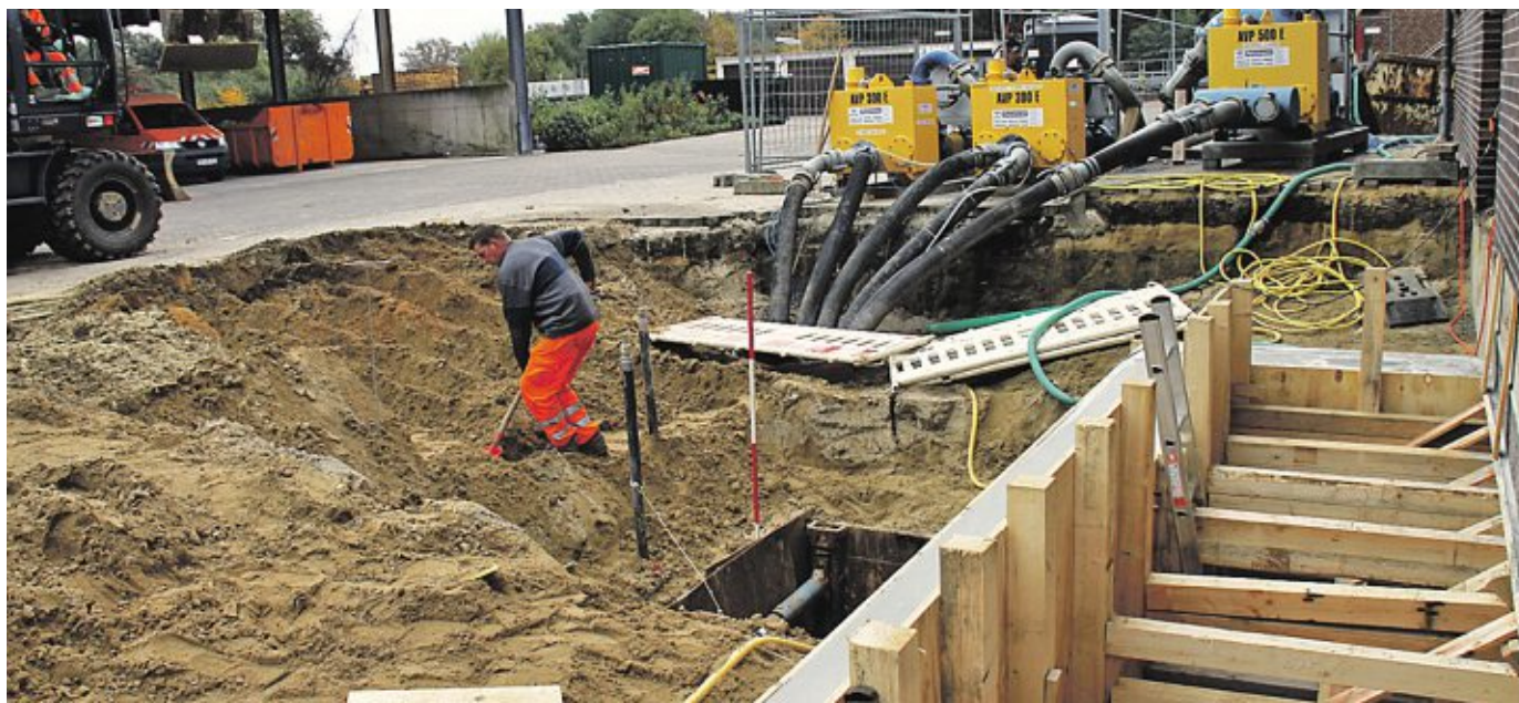
Die provisorische Abwasserüberleitung und der freigelegte Vorschacht.
