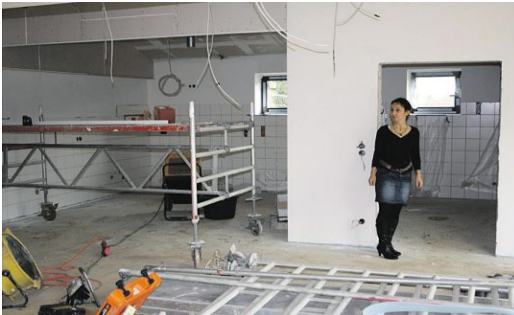
Noch sind die Handwerker aktiv. Kita-Leiterin Heike Teichmann ist guter Dinge, dass alles pünktlich fertig wird, wie hier im Küchentrakt. Achtermann
