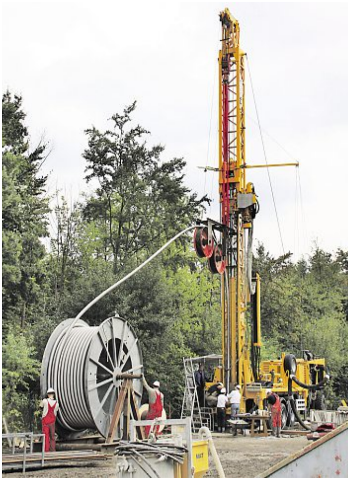
Das Foto entstand auf dem Gelände der Firma Wöltjen in Nienburg beim Einbau des Edelstahlwellrohrs.
