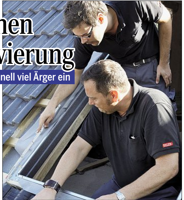
Die Renovierung des Hausdachs sollte man besser Profis überlassen. Foto: Velux
