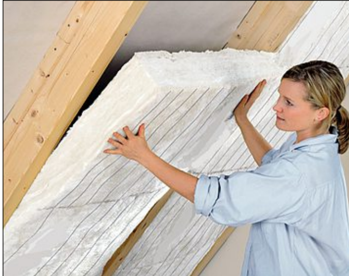
Beim Ausbau des Dachbodens besonders wichtig: die richtige Dämmung. Foto: Fachverband Mineralwolleindustrie
