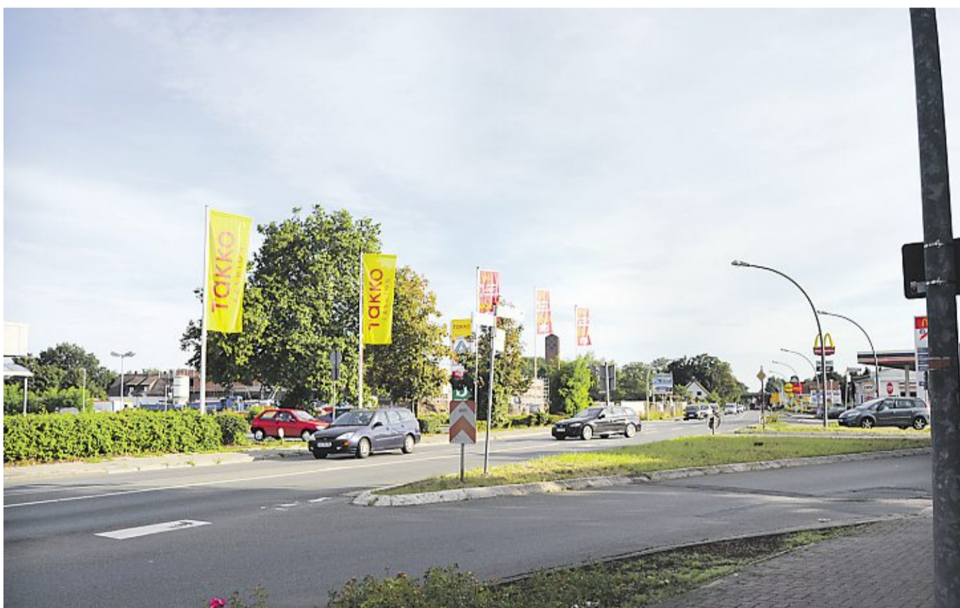
E-Center-Kreisel oder herkömmliche Einmündung mit Ampel? Am Donnerstag wird in Nienburg erneut beraten. So gut wie sicher ist dagegen, dass im kommenden Jahr in etwa 500 Meter Entfernung der Nordring-Kreisel gebaut wird. Hageböling
