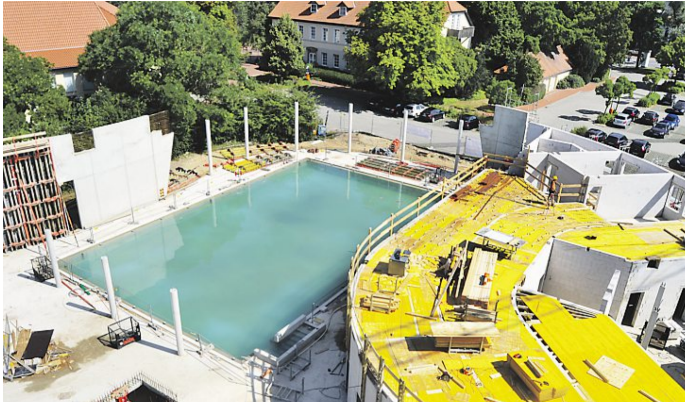
Das Sportbecken aus der Kran-Perspektive. Zumindest auf den ersten Blick lädt es bereits zum Baden ein.
