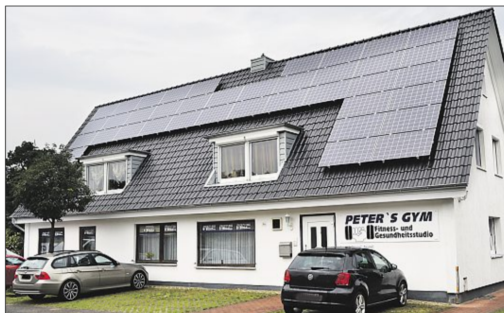
Eigentlich sollte nur das Bad vergrößert werden ... Nach gut siebenwöchiger Umbauzeit präsentiert sich das Wohn- und Geschäftshaus der Familie Lankau an der Ostlandstraße in Langendamm mit einem neuen Dach, Sonnenkollektoren, neuen Fenstern und frisch isolierten Wänden.
