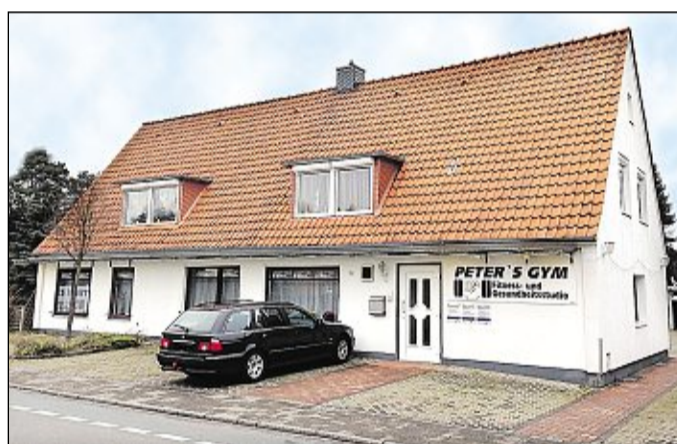
Dieses Foto von Architekt Gerald Christian verdeutlicht, wie das Gebäude vor der Sanierung ausgesehen hat.
