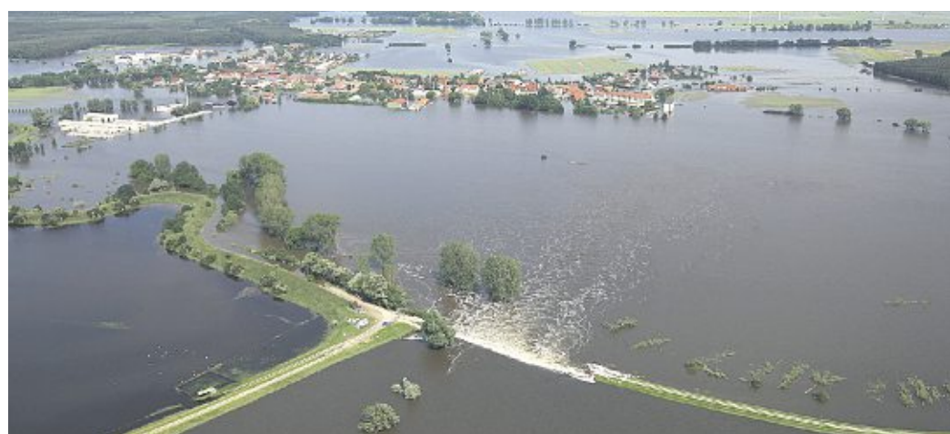
Der am 10. Juni geborstene Deich der Elbe bei Fischbach sollte gestern verschlossen werden.
