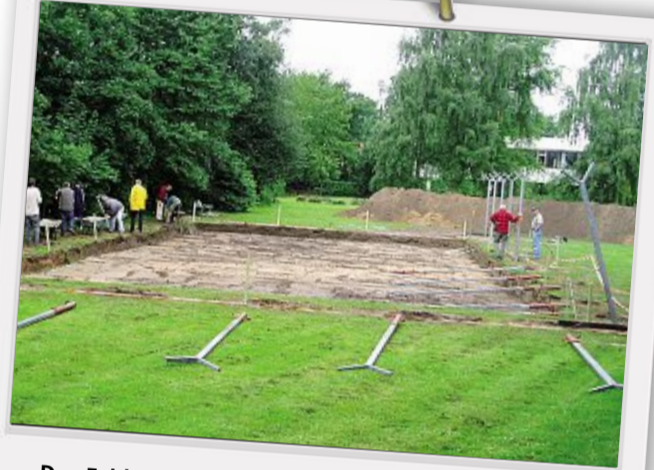
Das Feld wurde ausgekoffert, der Zaun aufgestellt.
