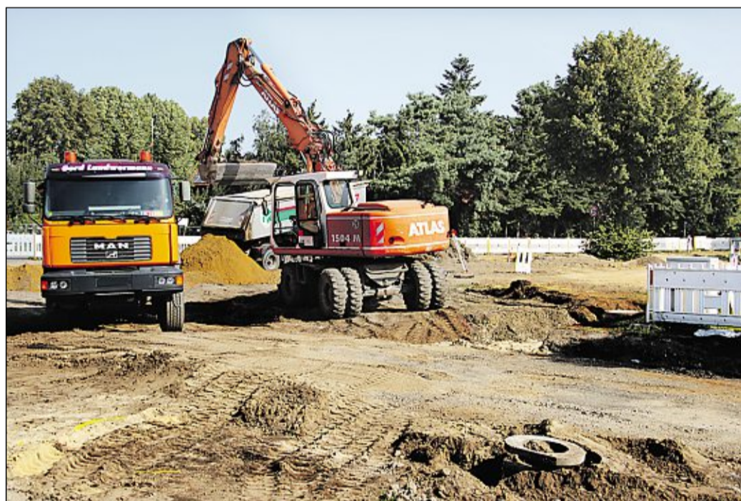
Die Bauarbeiten gingen zügig voran, hier ein Foto aus dem Monat September.
