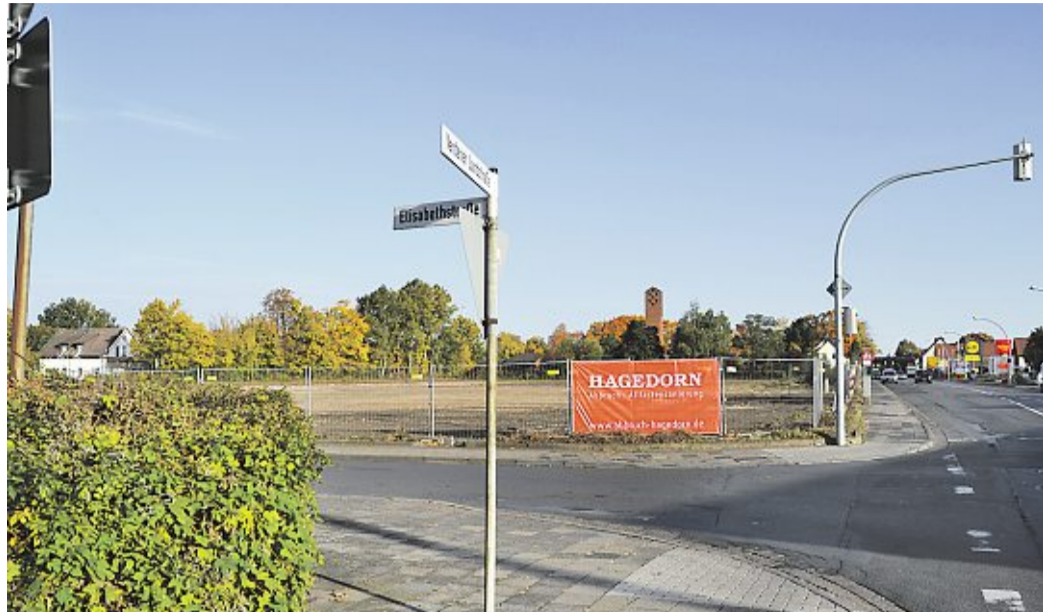
Das Abbruchunternehmen hat ganze Arbeit geleistet. Bereits seit Wochen präsentiert sich das Gelände, auf dem das E-Center entstehen soll, als absolut plane Ebene. Baubeginn soll noch in diesem Jahr sein. Foto: Hageböling
