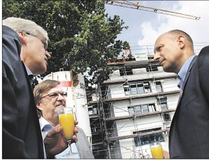
Das Wohnungsunternehmen GBN feierte nun Richtfest des Mietshauses an der Neißestraße. Foto: Stüben
