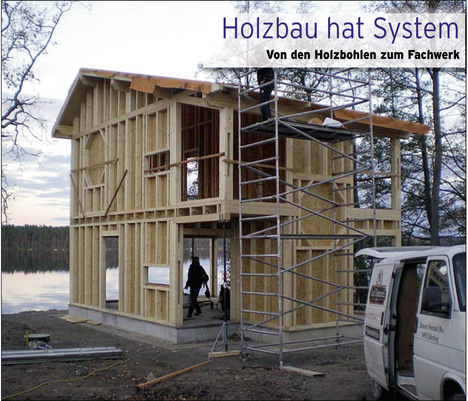
Moderne Holzständerkonstruktionen sind stabil, dauerhaft und umweltfreundlich. Foto: Graf
