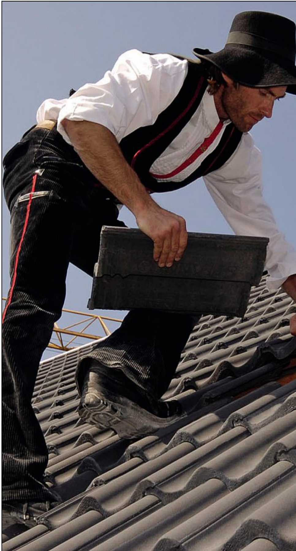
Dachreparaturen werden am besten vom Fachmann ausgeführt. Foto: Nelskamp
