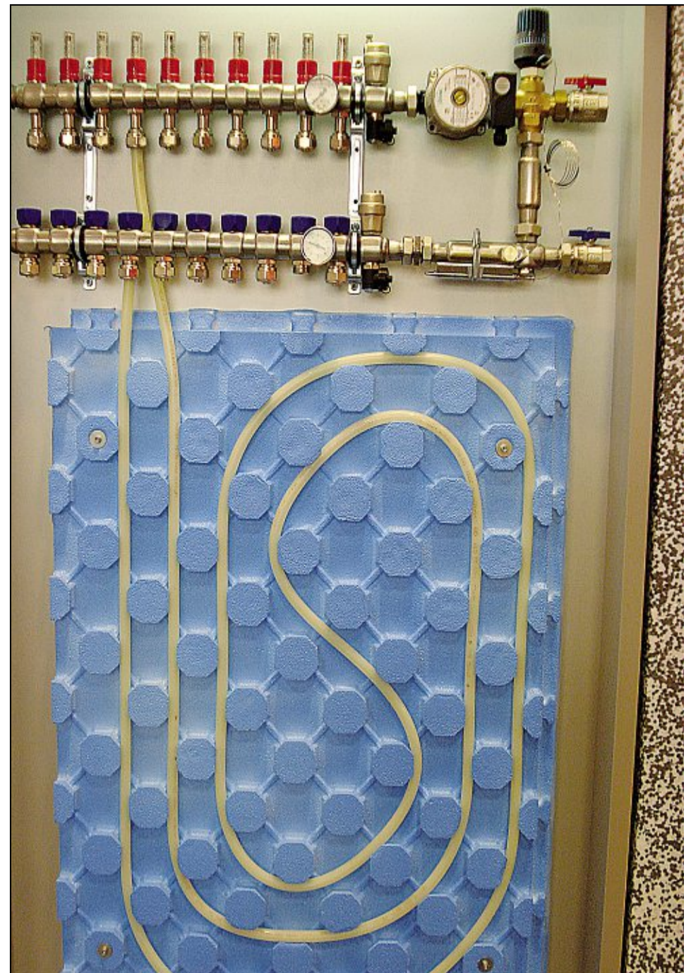
Modell einer Fußbodenheizung mit Heizschlangen Foto: Busche
